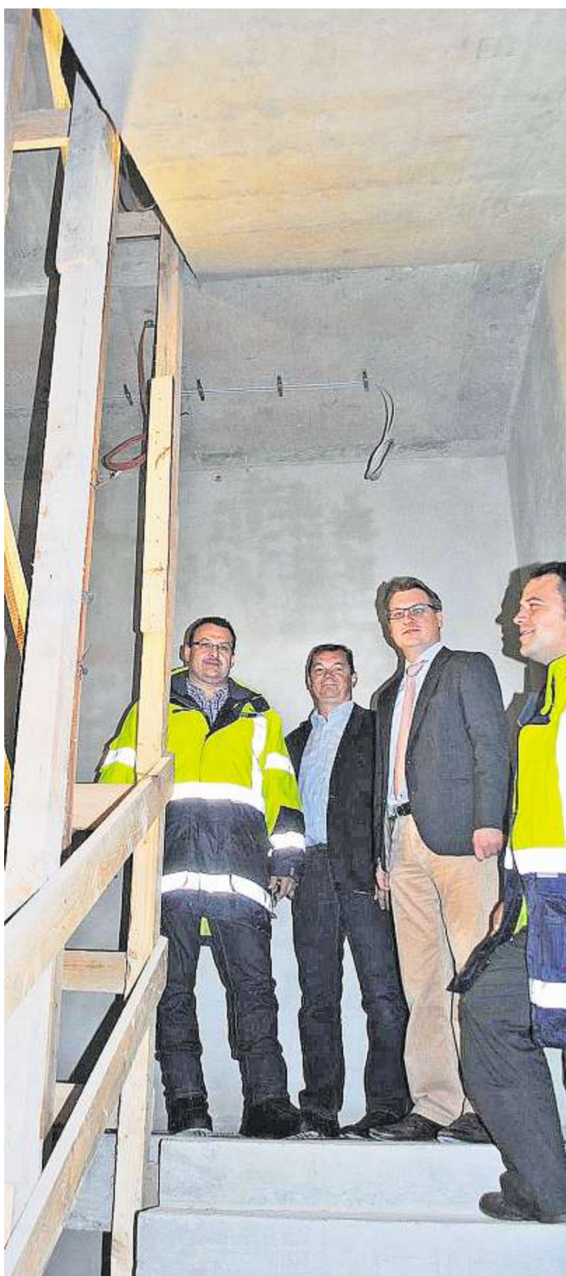
Besichtigung des neuen, zweiten Treppenhauses in der WMS
